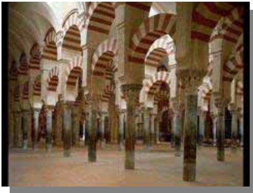
El problema fundamental es el cubrimiento de una caja tan grande. La solución más notable fue darle altura mediante el empleo de dos **soportes superpuestos**, una columna y sobre ella un pilar. El pilar soporta arcos de medio punto sobre los cuales descansa la techumbre de madera, y de los capiteles de las columnas salen arcos de herradura, son
